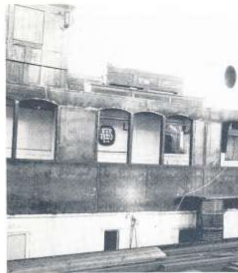
Här syns plåtskottet som ställts ända ute i sidan med speciella fönsteröppningar. Även frontskottet har utbytts mot stålskott i samma stil. Foto 14 nov 1976 Christer Samuelsson
